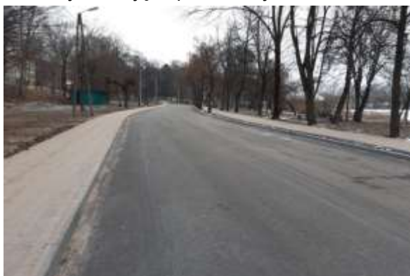
ul. Kajki- – zdjęcia po realizacji
