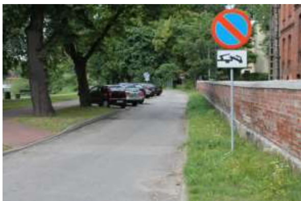
ul. Asnyka- zdjęcia sprzed realizacji
